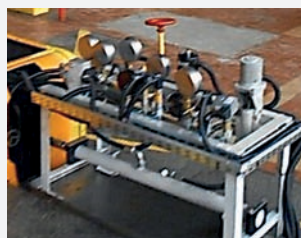
Rys. 20. Turbina Siemens 55 MW po modernizacji – stół zabezpieczeń
