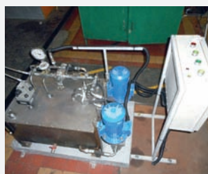
Rys. 18. Turbina Siemens 55 MW po modernizacji – stacja hydrauliczna
