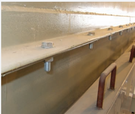
Rys. 4. Wymienione śruby łączące zasypnika, źródło: zdjęcie własne autora
