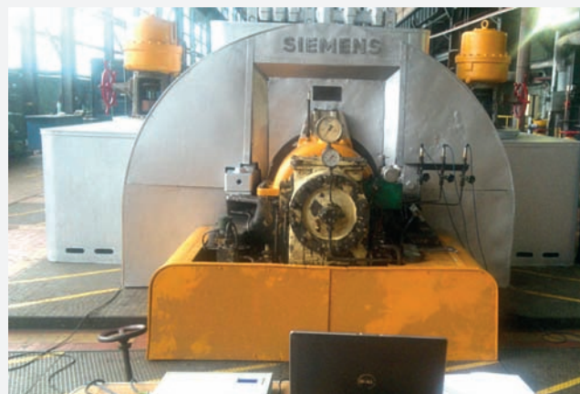
Rys. 4. Turbina Siemens 55 MW przed modernizacją
