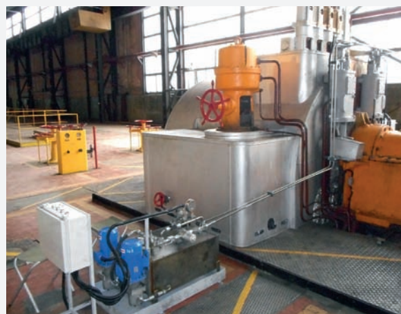
Rys. 17. Turbina Siemens 55 MW po modernizacji – zasilanie przetworników TM-25 LP
