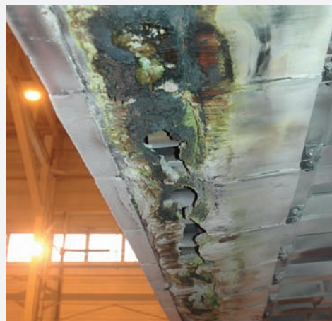
Rys. 3. Uszkodzona osłona termiczna szuffli zasypnika po półrocznym okresie eksploatacji, źródło: zdjęcie własne autora
