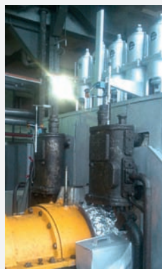
Rys. 5. Turbina Siemens 55 MW przed modernizacją
