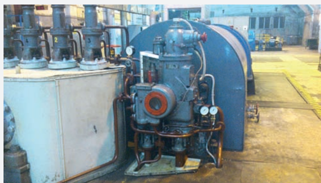
Rys. 1. Turbina PB8/4 przed modernizacją
