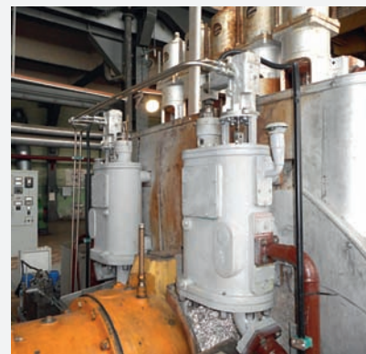
Rys. 6. Turbina Siemens 55 MW po modernizacji
