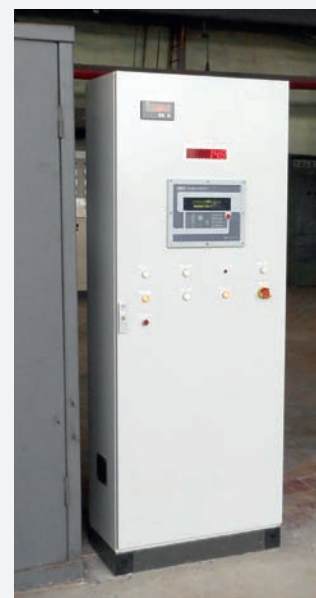
Rys. 19. Turbina Siemens 55 MW po modernizacji – szafa regulatora cyfrowego
