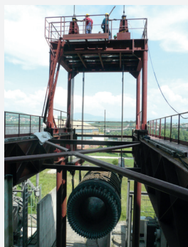
Widok opuszczanego uzwojenia generatora - TE Kakanj
