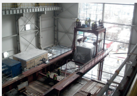
Widok z góry na podnoszony generator - EC1 Bielsko Biała
