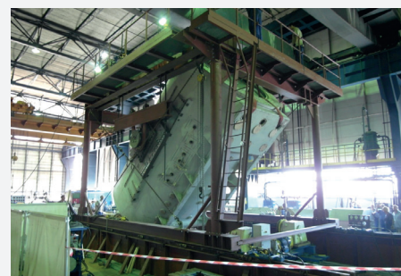
Obrót generatora - TE Tuzla
