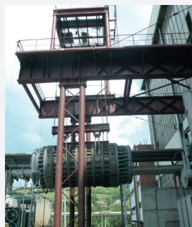
Widok konstrukcji wsporczej z zewnątrz maszynowni - TE Kakanj
