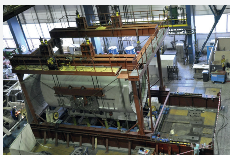
Generator przygotowany do opuszczenia na fundament - TE Tuzla
