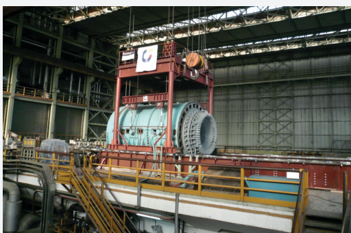
Podniesiony generator z fundamentów - TE Kakanj
