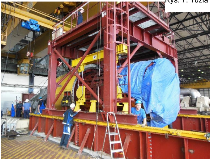
Rys. 7. Tuzla – obracanie stojana generatora
