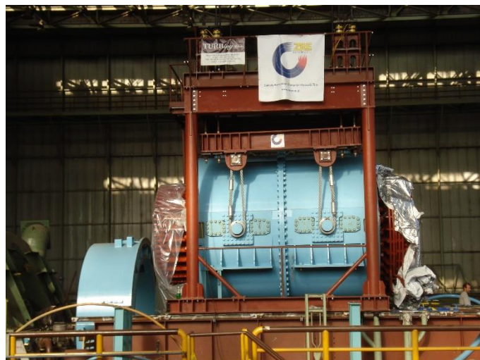
Zdj. 4 Kakanj – stojan generatora przed opuszczeniem na fundament
