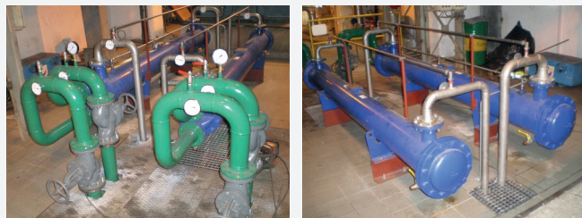
Rys. 25. Zainstalowane nowe chłodnice oleju smarowego i roboczego
