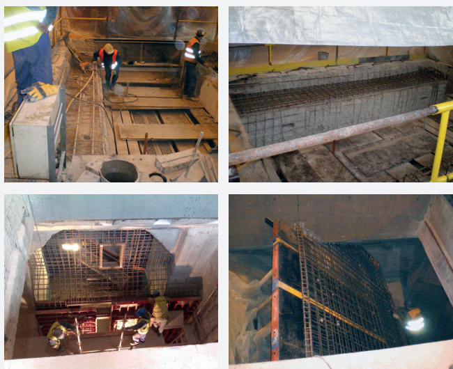
Rys. 27. Prace adaptacyjno-budowlane w obrębie fundamentu generatora
