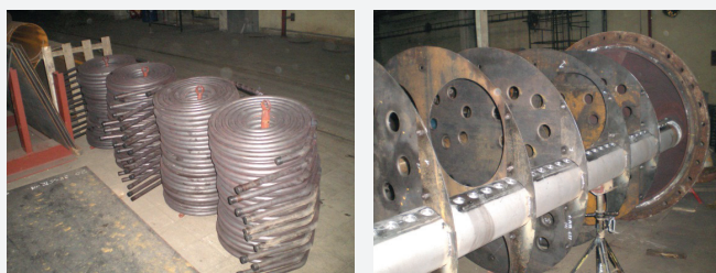
Rys. 21. Montaż elementów nowych wymienników regeneracyjnych
