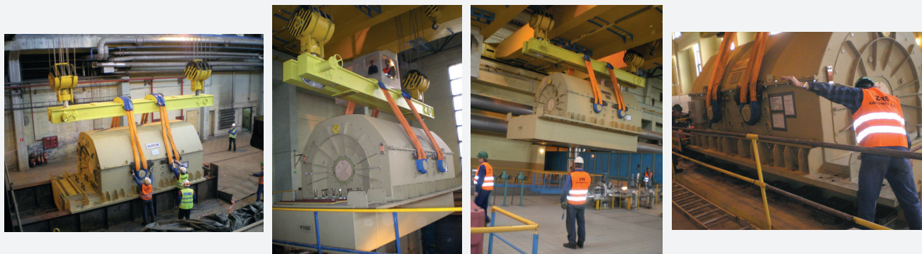
Rys. 30. Transport wewnętrzny stojana generatora o wadze 72 t
