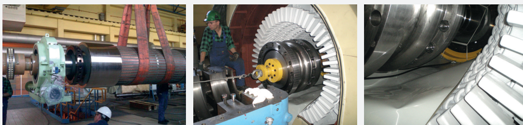
Rys. 31. Montaż wirnika generatora w rdzeniu stojana generatora o wadze 72 t
