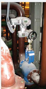
Rys. 11. Zawór mieszalnikowy regulujący temp. oleju smarnego
