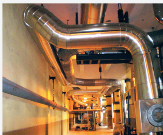
Rys. 12. Rurociąg układu zasilania parą podgrzewacza powietrza nowego kotła
