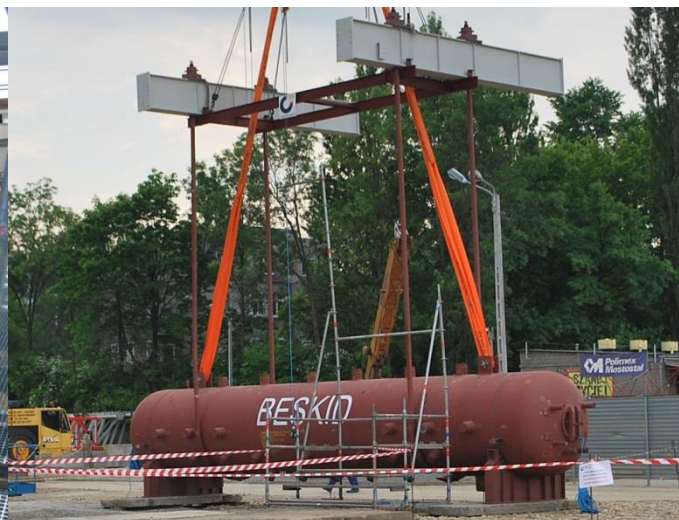
Rys. 21. Przygotowanie do transportu walczaka „Beskid” bloku 50MW w EC Bielsko-Biała
