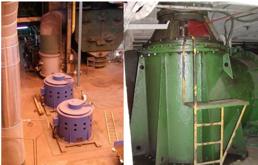
Rys. 15. Widok na pompy wody chłodzącej bloku nr 12 w El. Łaziska
